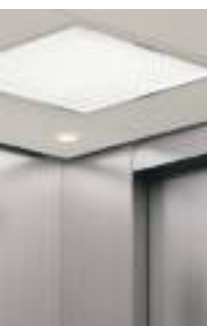
Iluminación: Central y luces tenues (LEDs).
