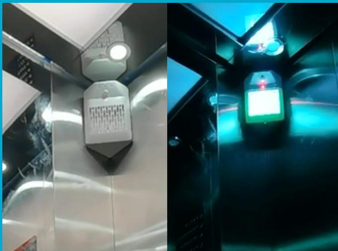
Cuando las bacterias, los virus y los protozoos se exponen a las longitudes de onda germicidas de la luz UV, se vuelven incapaces de reproducirse e infectar. La ventajas de este sistema frente a otros son evidentes, ya que la desinfección con luz ultravioleta funciona sin la necesidad de añadir ningún producto químico durante todo el proceso de desinfección y, al tratarse de un sistema físico, los microorganismos no son capaces de generar resistencia al proceso de desinfección.
