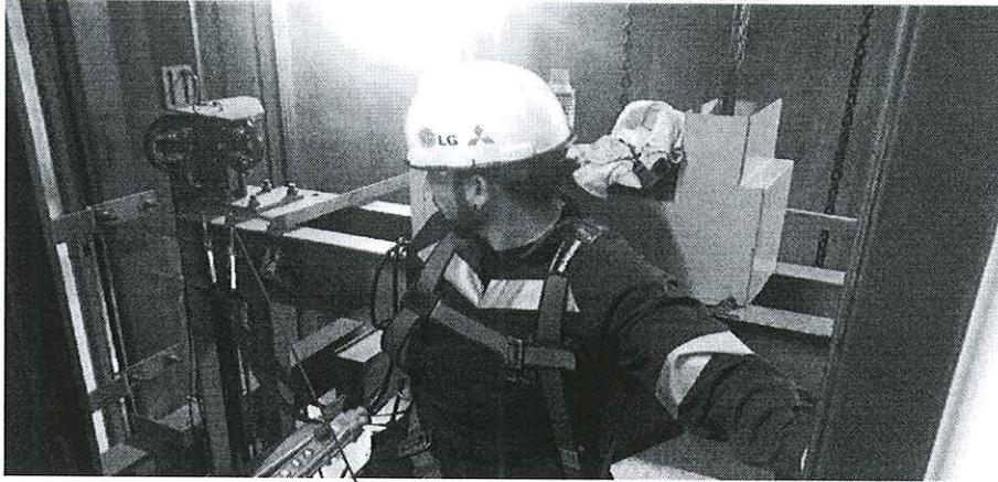
Para este modelo DI4 de ascensores, aprovecharemos las perforaciones que tiene el Yugo para enganchar nuestro cabo de vida, cabe señalar que por el tamaño de la cabina, no tenemos riesgos de atrapamiento del arnés de Seguridad, ya que no pasara por partes móviles del ascensor tal y como muestra la imagen.
